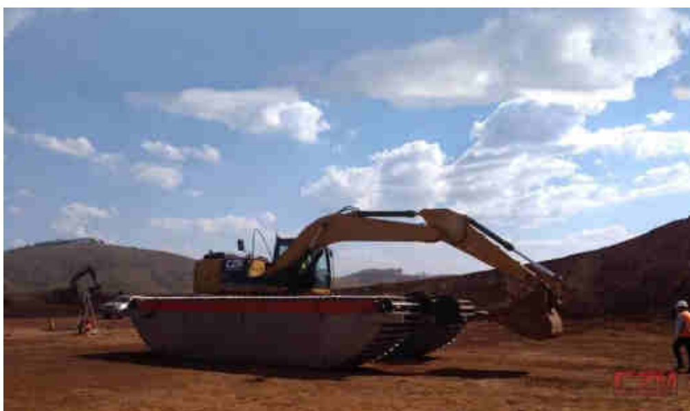
Foto 2.2 – Modelo de escavadeira anfíbia usada como base para o dimensionamento
