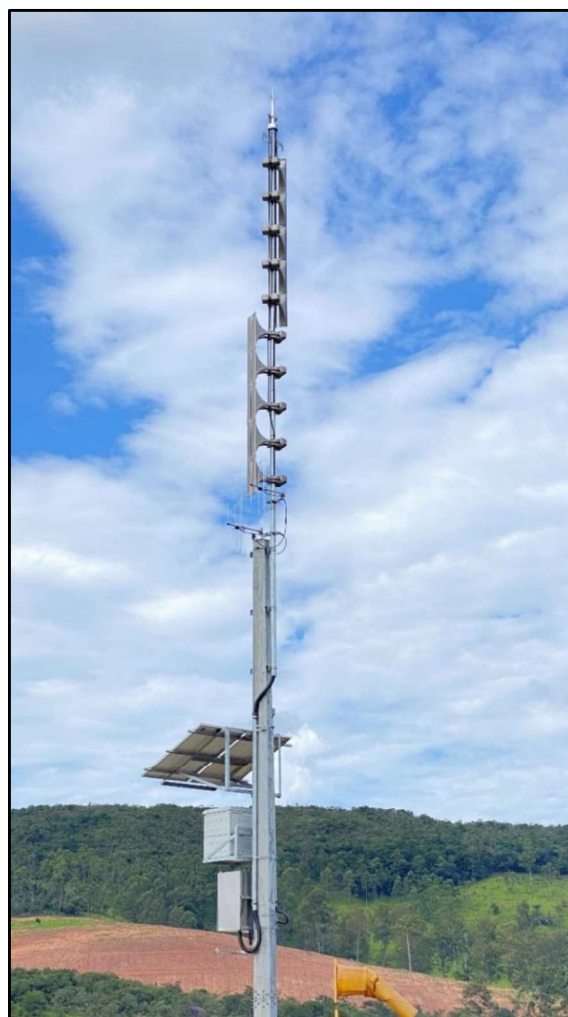
Figura 13.1 – Sirene implantada próxima a ZAS da mancha de inundação da estrutura de contenção de rejeitos B1
