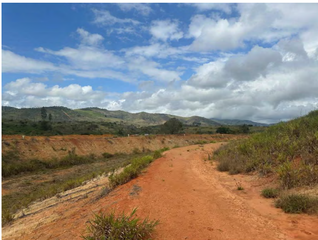
Foto 20 – Talude de corte do Canal extravasor – sem sinais de empoçamento de água. Vista em direção ao emboque.
