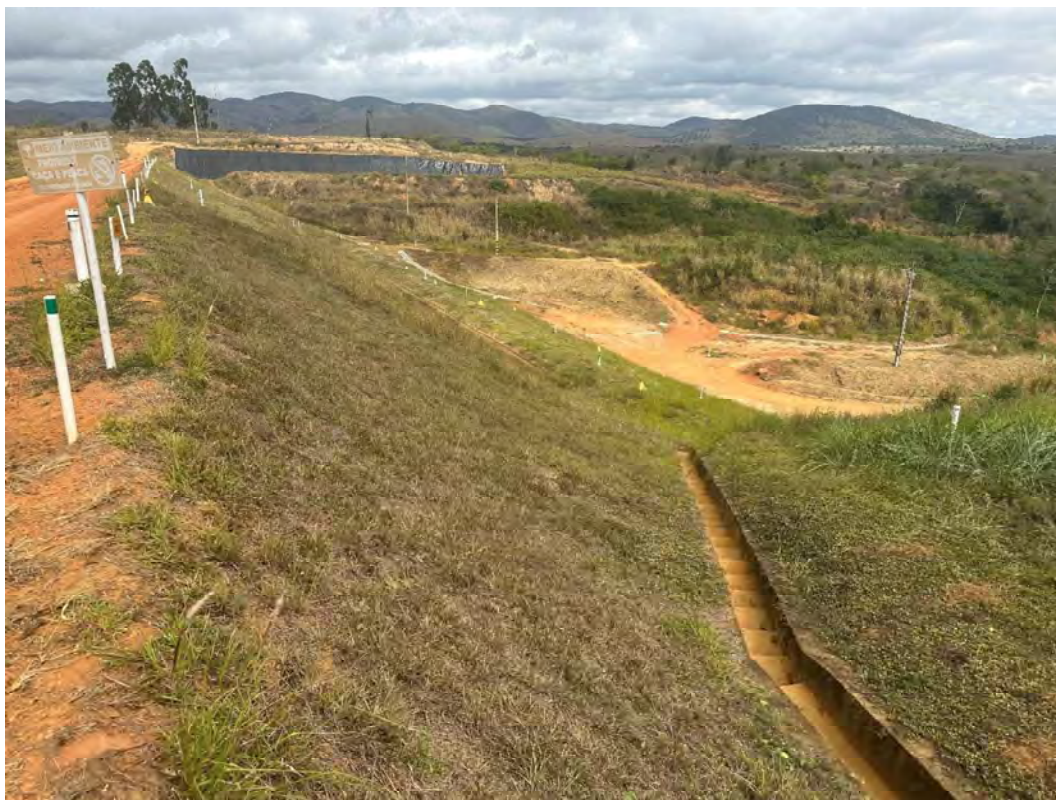
Foto 9 – Talude de jusante – vista para a ombreira esquerda.
