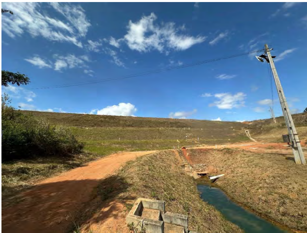
Foto 13 – Vista frontal do talude de jusante.
