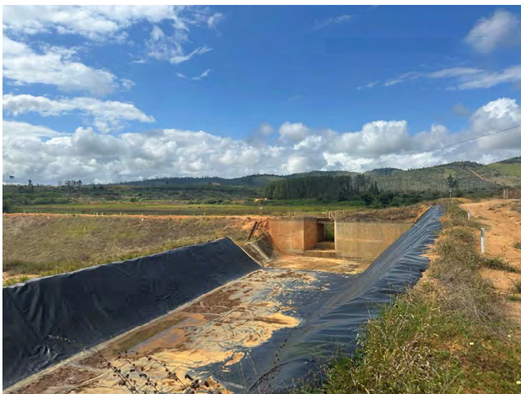
Foto 22 – Desemboque do extravasor – detalhe da soleira de concreto
