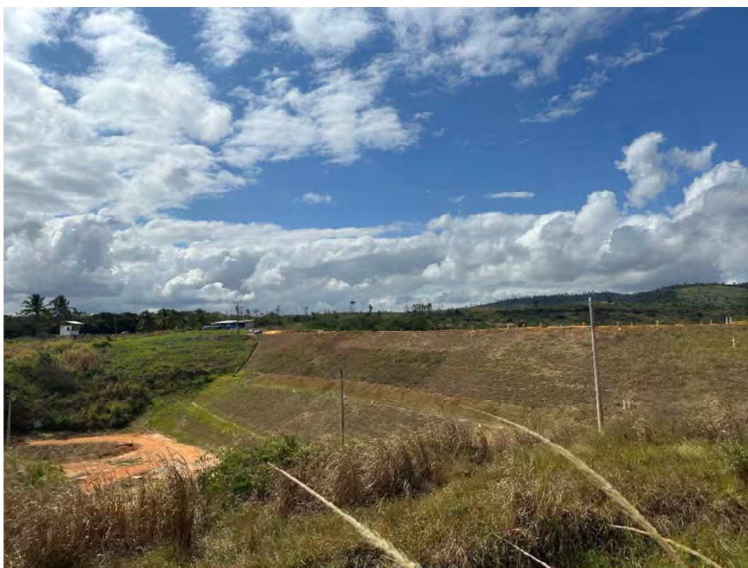
Foto 8 – Talude de jusante – vista para a ombreira direita.
