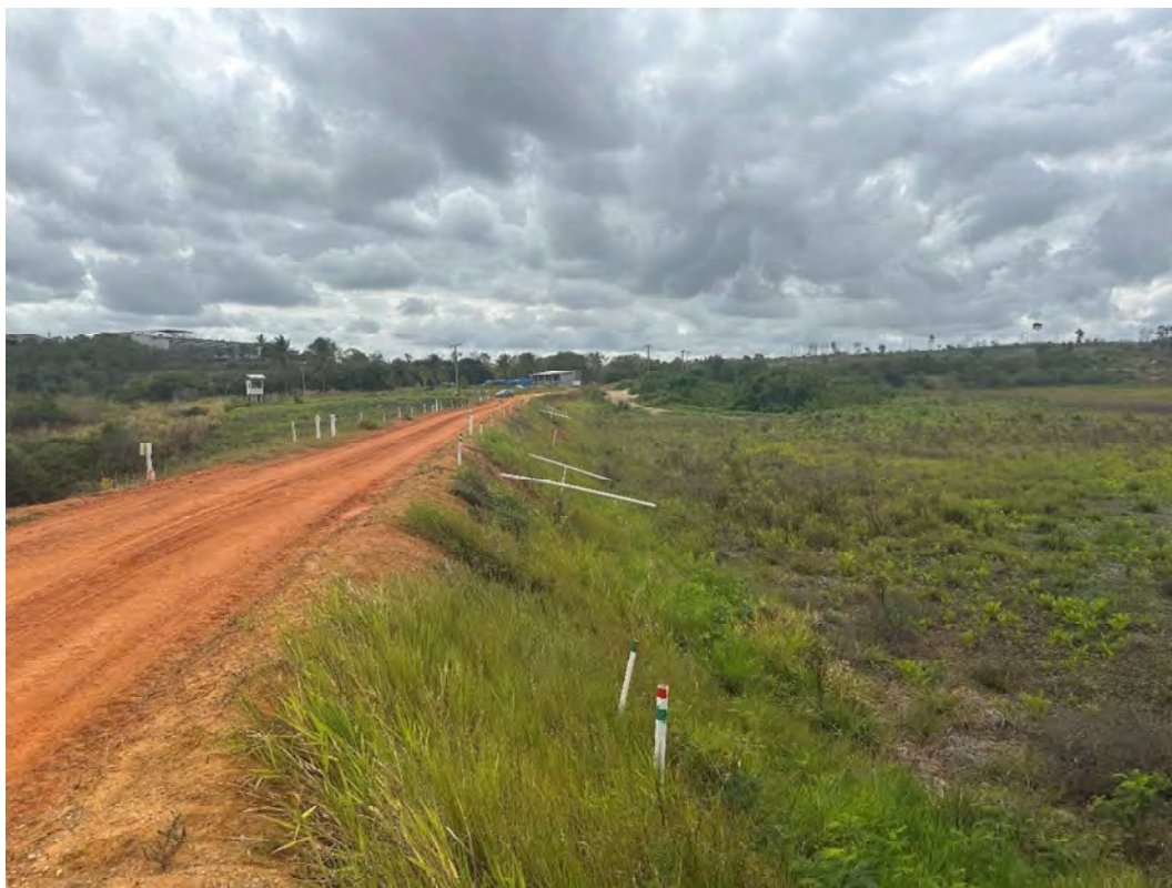
Foto 7 – Talude de montante – vista para a ombreira direita.
