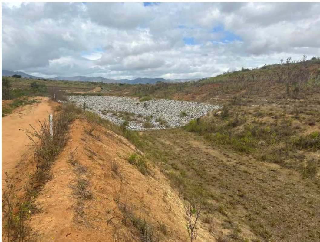
Foto 17 – Canal extravasor – vista para o emboque. Não há assoreamentos.
