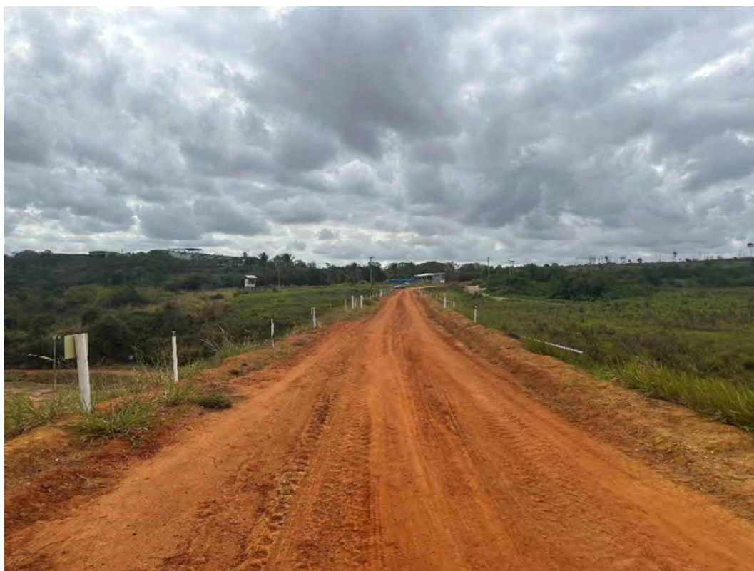
Foto 4 – Crista da barragem – vista para a ombreira direita.
