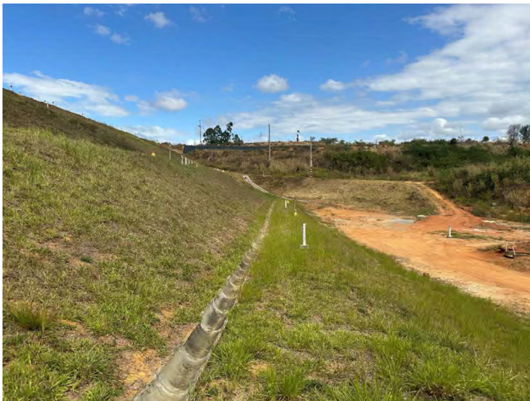
Foto 11 – Berma da cota 170 m (var.) – vista para a ombreira esquerda.
