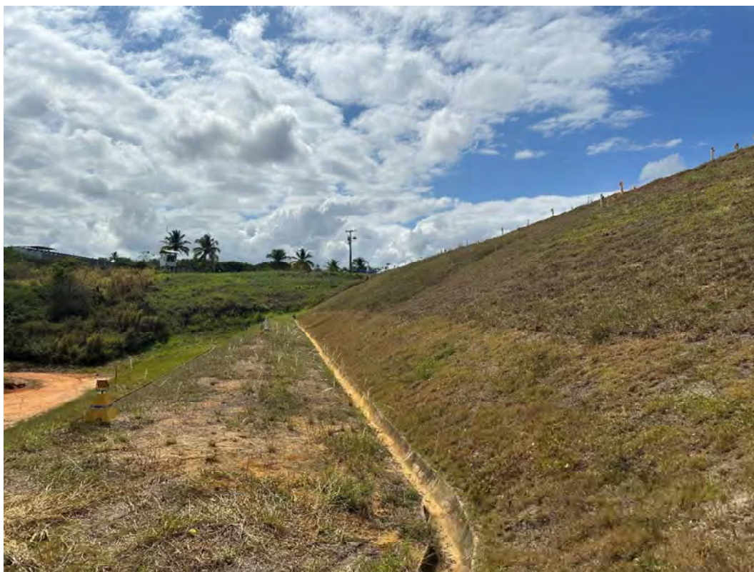
Foto 10 – Berma cota 175 m (var.) – Vista para a ombreira direita.
