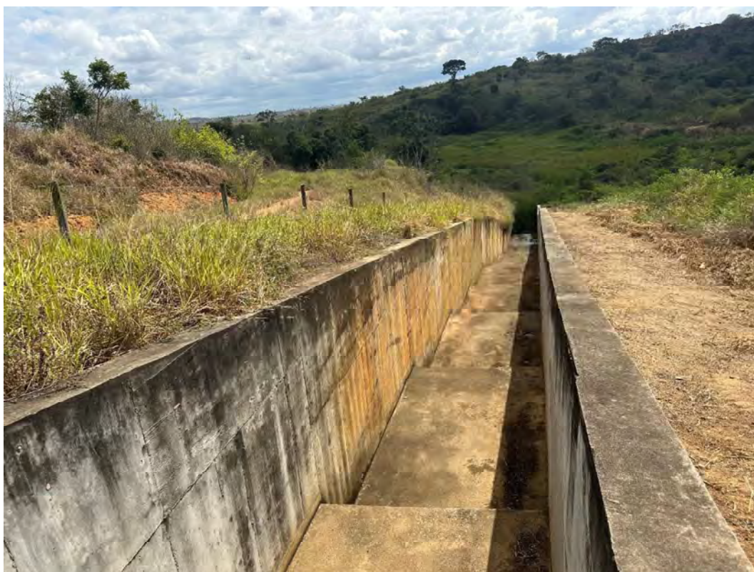
Foto 24 – Trecho do canal extravasor em concreto – Escada hidráulica.
