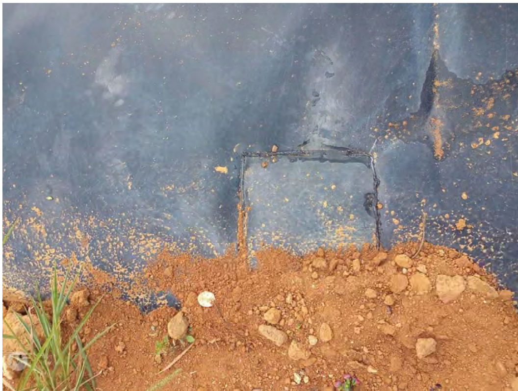
Foto 1 – Evidencia da ação "i" - executada em 18/06/25.
