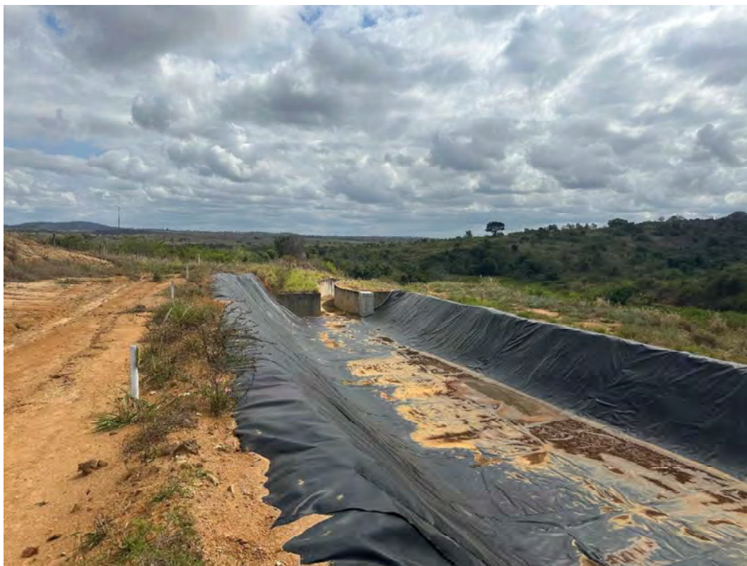
Foto 23 – Vista do canal do extravasor – vista para jusante
