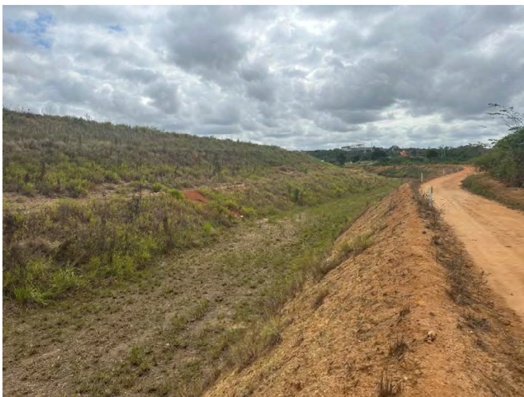
Foto 18 – Canal extravasor – vista para jusante. Não há assoreamentos.
