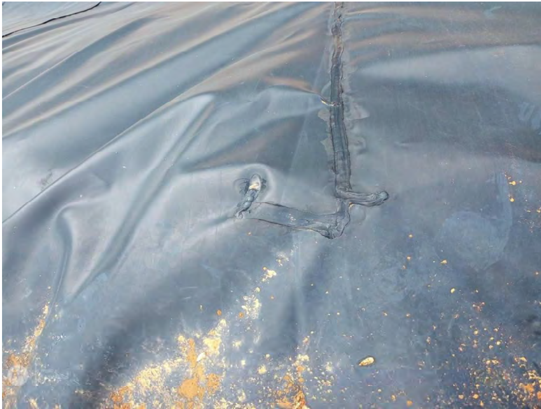
Foto 2 – Evidencia da ação “i” - executada em 18/06/25.
