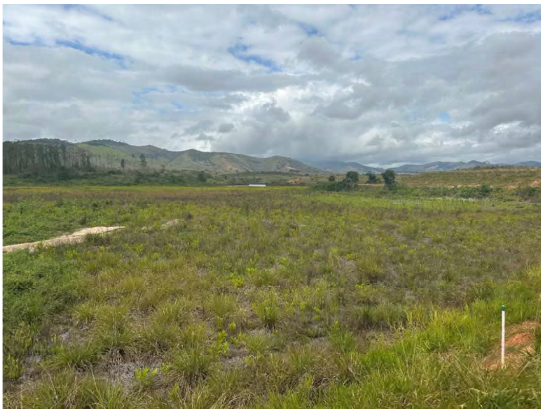
Foto 3 – Reservatório da barragem.
