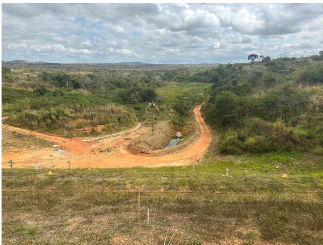
Foto 12 – Área de jusante – detalhe para o canal de drenagem do medidor de vazão.
