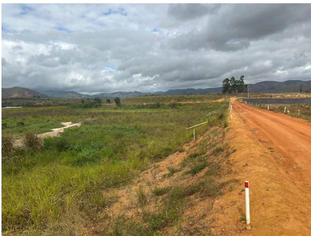
Foto 6 – Talude de montante – vista para a ombreira esquerda.
