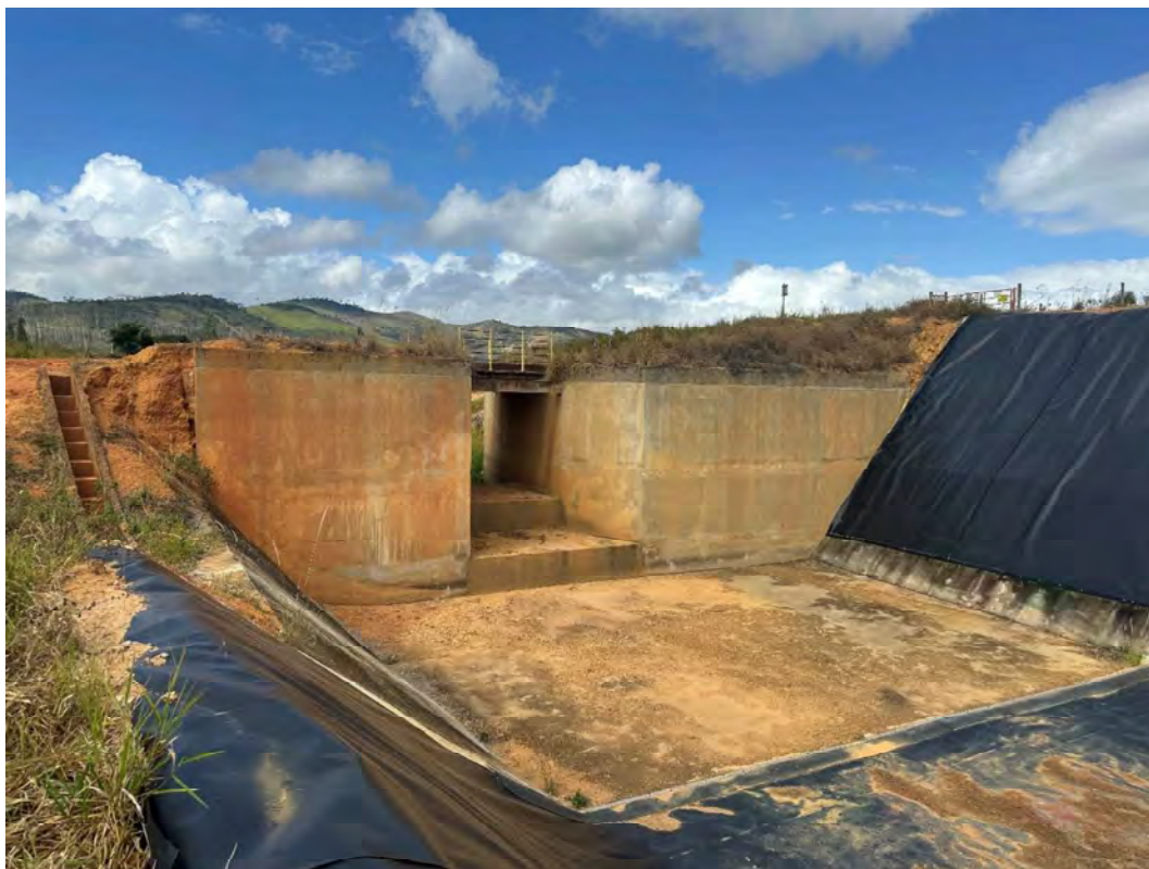
Foto 21 – Desemboque do extravasor – detalhe da soleira de concreto
