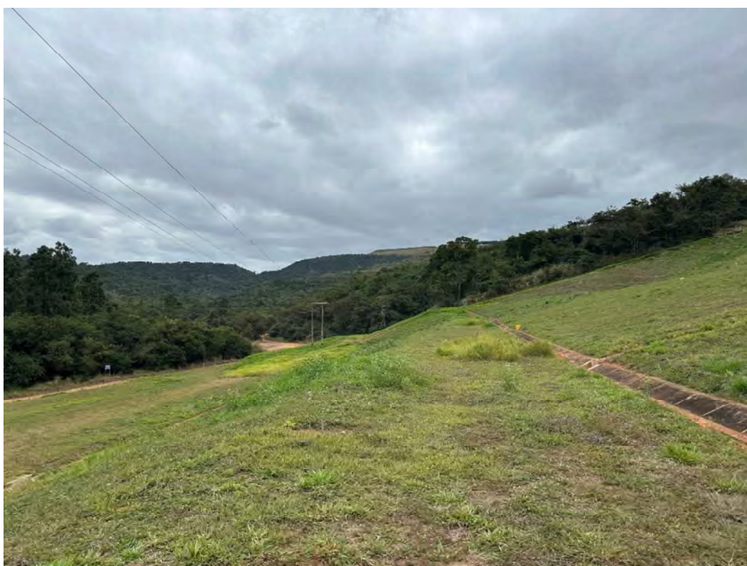
Foto 20 – Talude de jusante – Berma da cota 601 - Vista para a ombreira direita.
