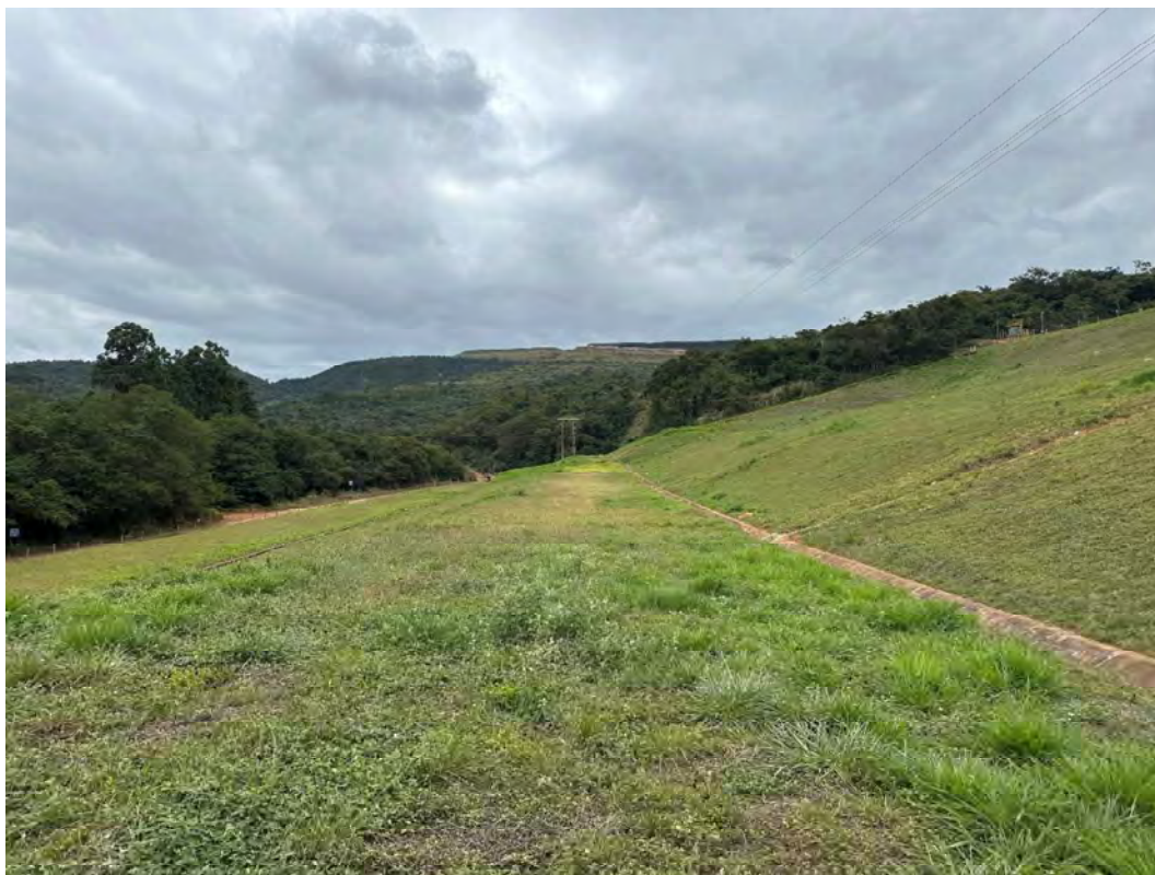
Foto 23 – Talude de jusante – Berma da cota 595 - Vista para a ombreira direita.
