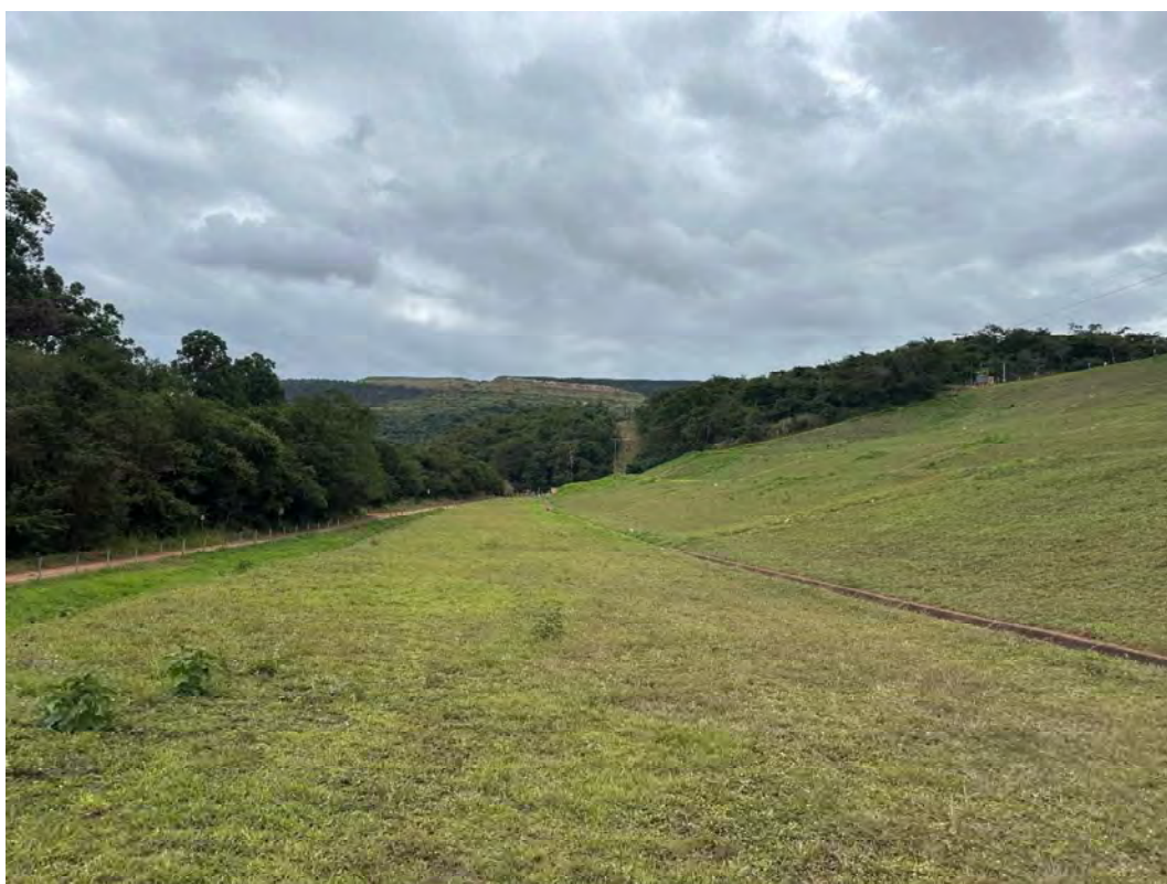
Foto 26 – Talude de jusante – Berma da cota 590 - Vista para a ombreira direita.
