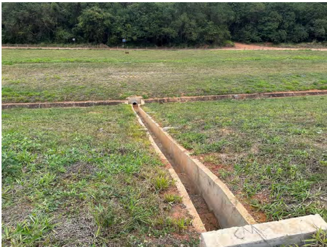
Foto 21 – Talude de jusante – nova descida d’água em degraus conectando as drenagens das bermas 595 e 601 (est. 9).
