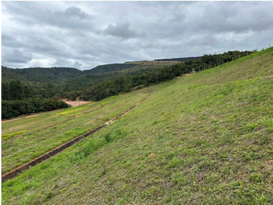
Foto 16 – Talude de jusante – Face entre as cotas 608 e 616 - Vista para a ombreira direita.
