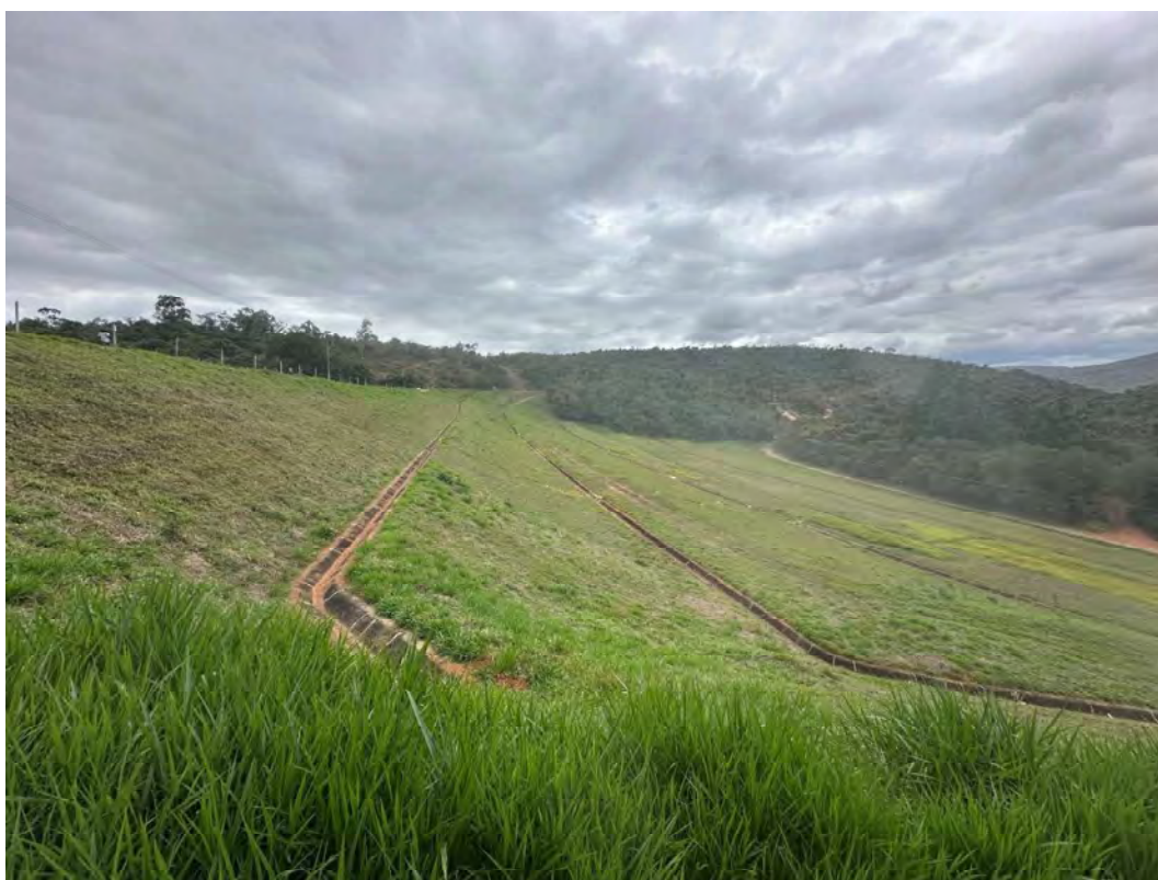
Foto 12 – Talude de jusante - Vista para a ombreira esquerda.
