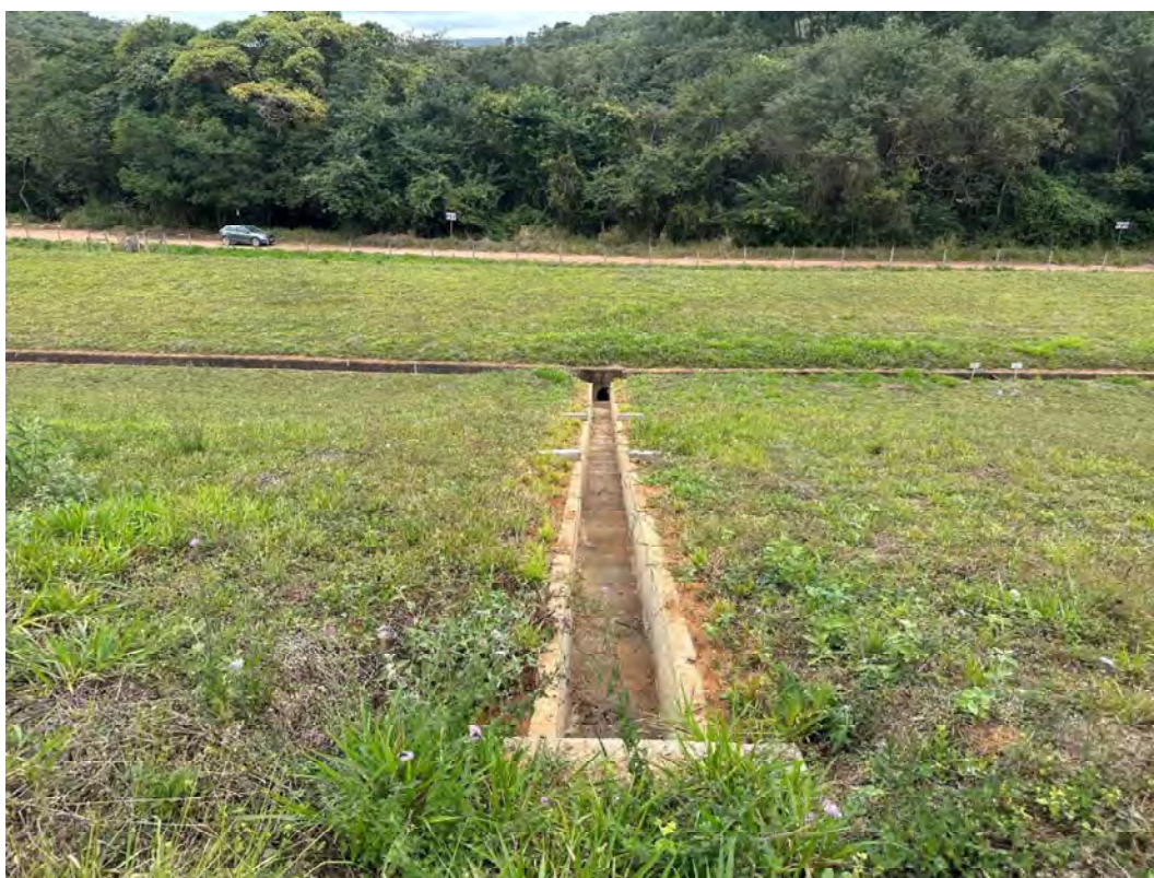
Foto 24 – Talude de jusante – nova descida d’água em degraus conectando as drenagens das bermas 590 e 595 (est. 6).
