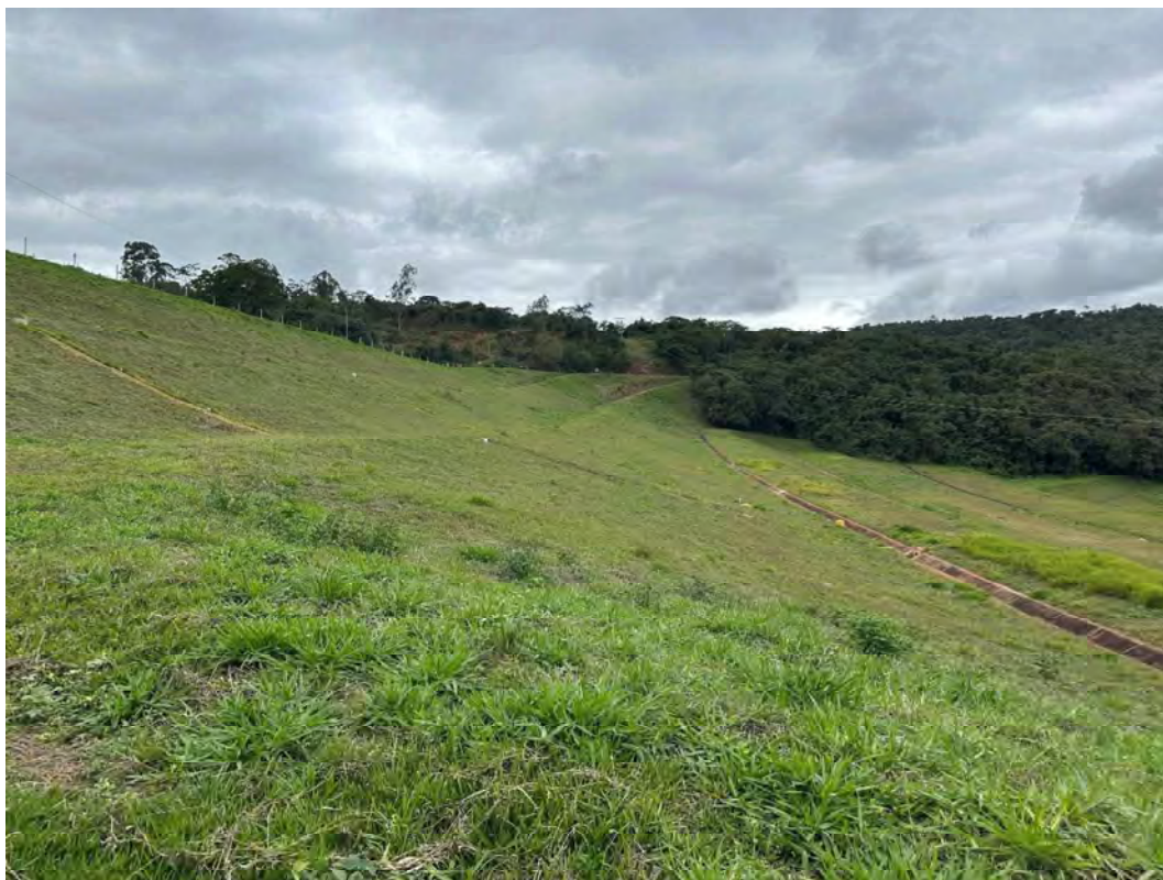
Foto 19 – Talude de jusante – Face entre as cotas 601 e 608 - Vista para a ombreira esquerda.
