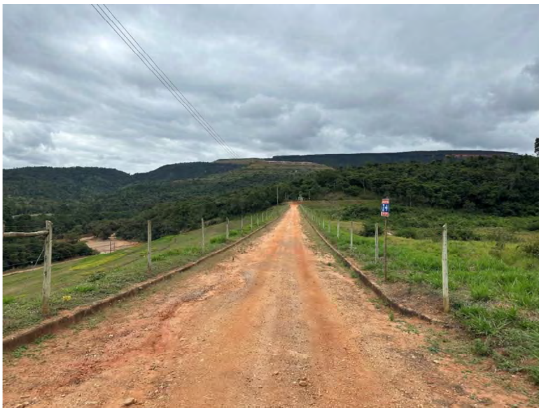
Foto 1 - Crista da barragem - Vista para a ombreira direita.
