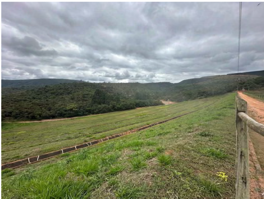
Foto 11 – Talude de jusante - Vista para a ombreira direita.
