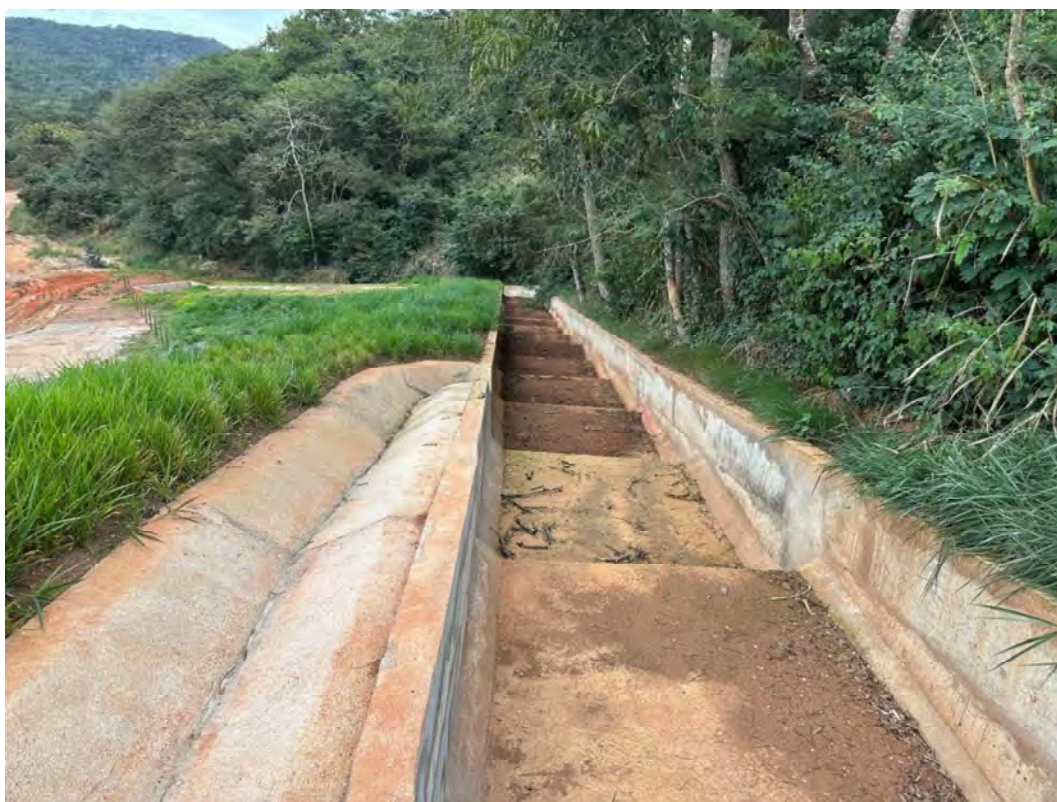
Foto 10 – Canal extravasor em degraus.
