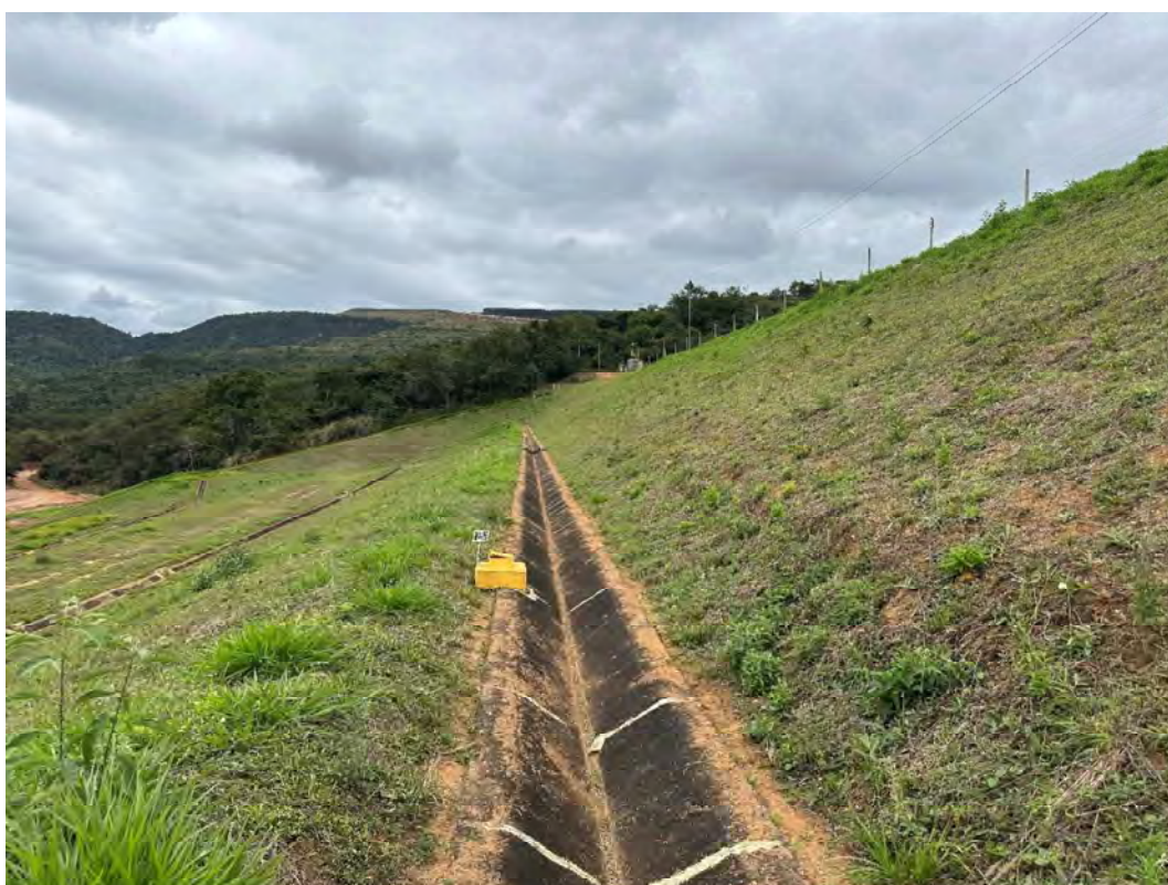
Foto 14 – Talude de jusante – Berma da cota 616 - Vista para a ombreira direita.
