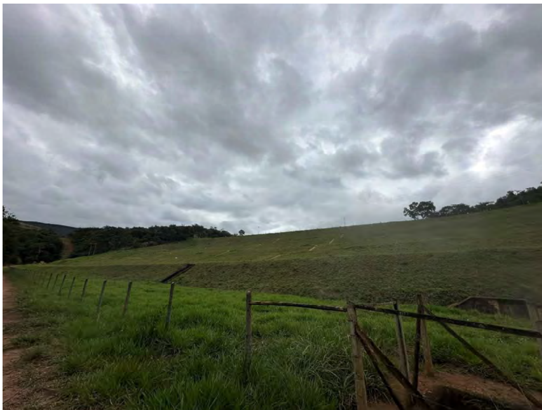
Foto 27 – Talude de jusante –Vista frontal.
