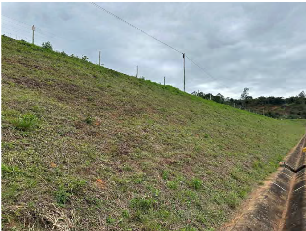
Foto 13 – Talude de jusante – Face entre as cotas 616 e 625 - Vista para a ombreira esquerda.
