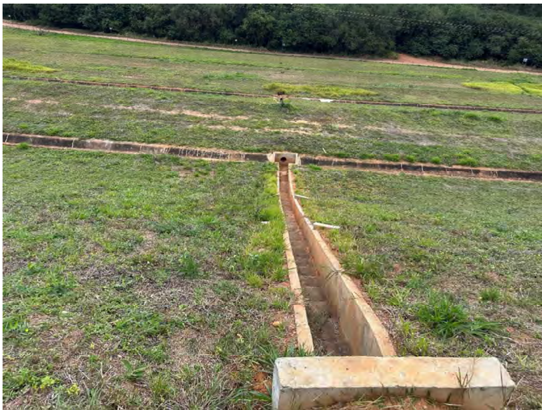
Foto 15 – Talude de jusante – nova descida d’água em degraus conectando as drenagens das bermas 608 e 616 (est. 9).
