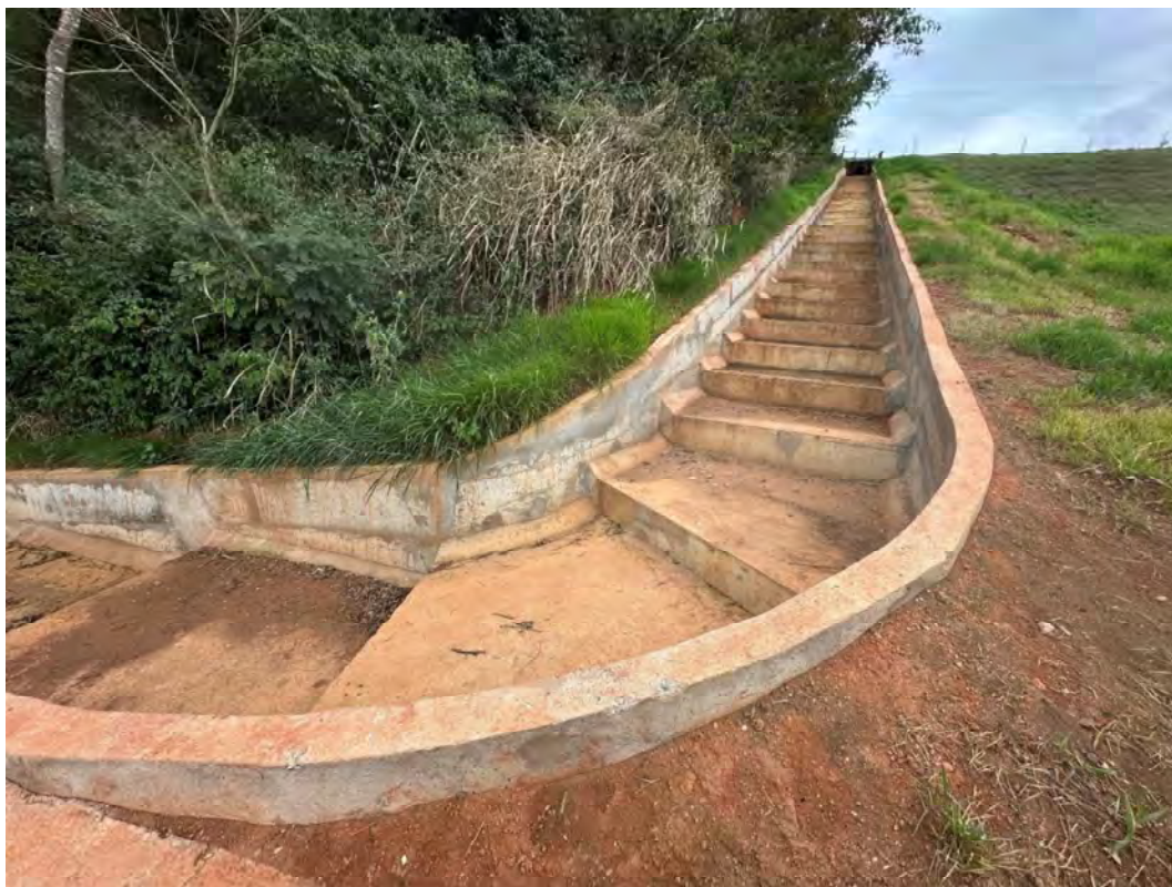
Foto 9 – Canal extravasor em degraus.
