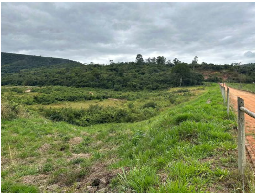
Foto 5 – Talude de montante - Vista para a ombreira esquerda.
