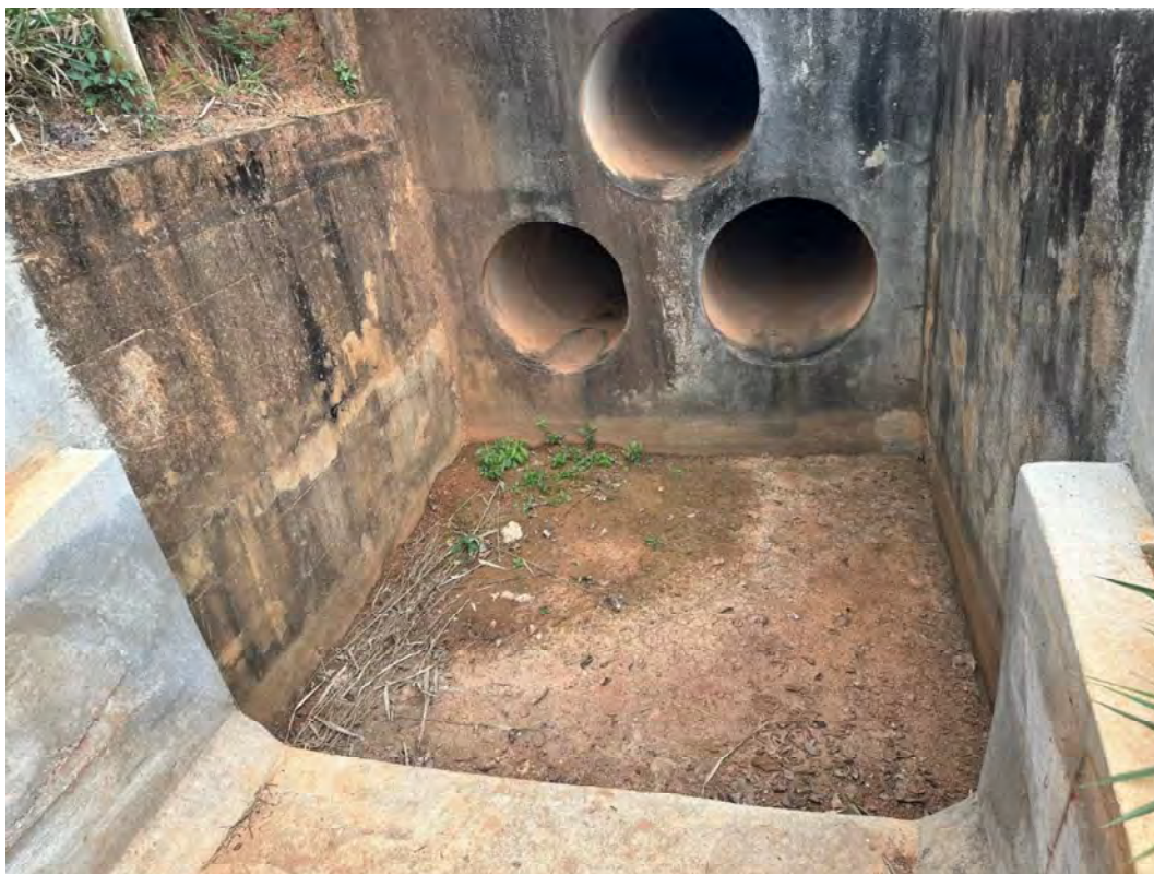
Foto 7 – Desemboque do extravasor.
