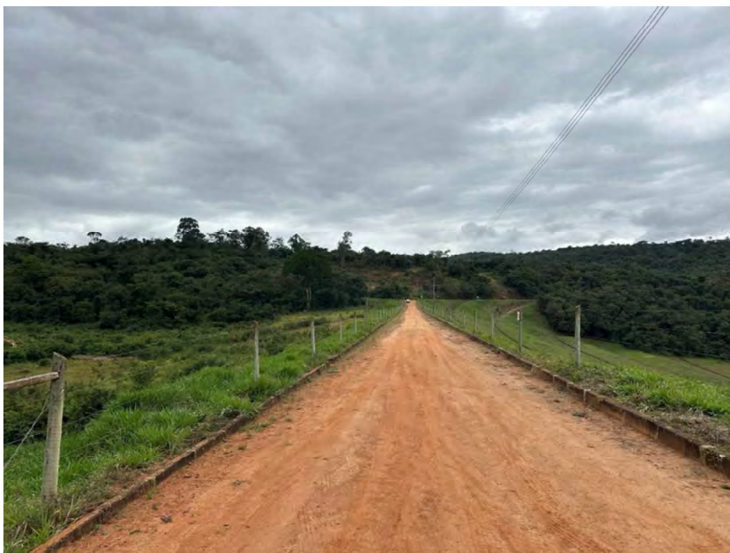
Foto 2 - Crista da barragem - Vista para a ombreira esquerda.
