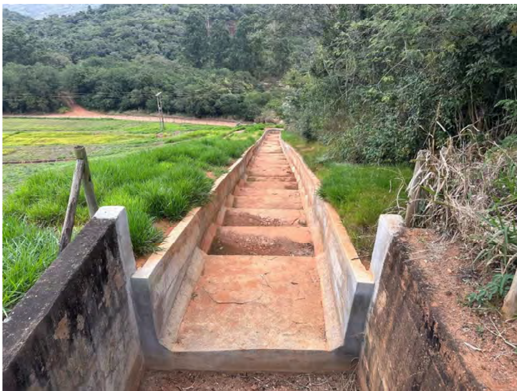
Foto 8 – Canal extravasor em degraus.
