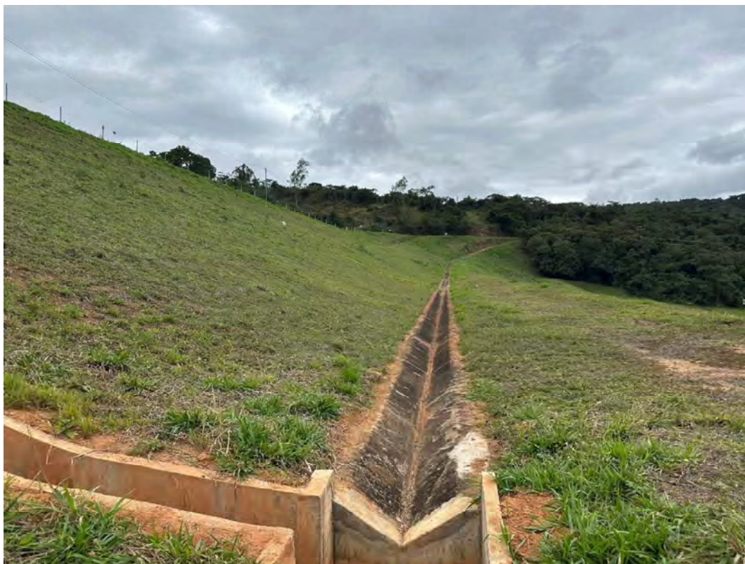
Foto 17 – Talude de jusante – Berma da cota 608 - Vista para a ombreira esquerda.
