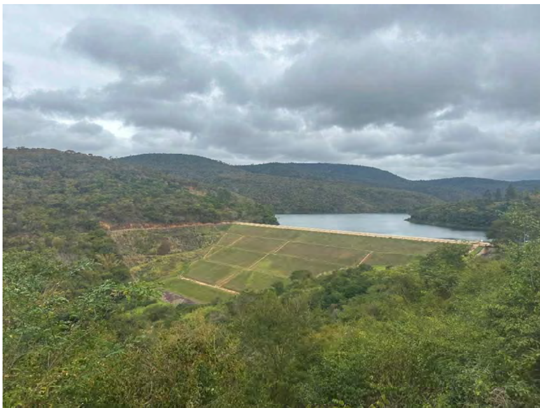
Foto 4 – Vista geral da barragem.
