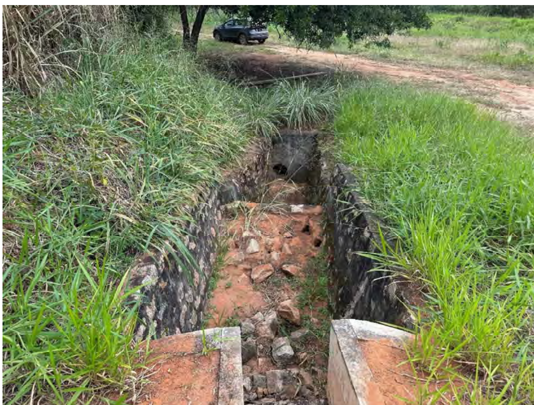
Foto 25 – Dissipação da drenagem superficial da ombreira esquerda.
