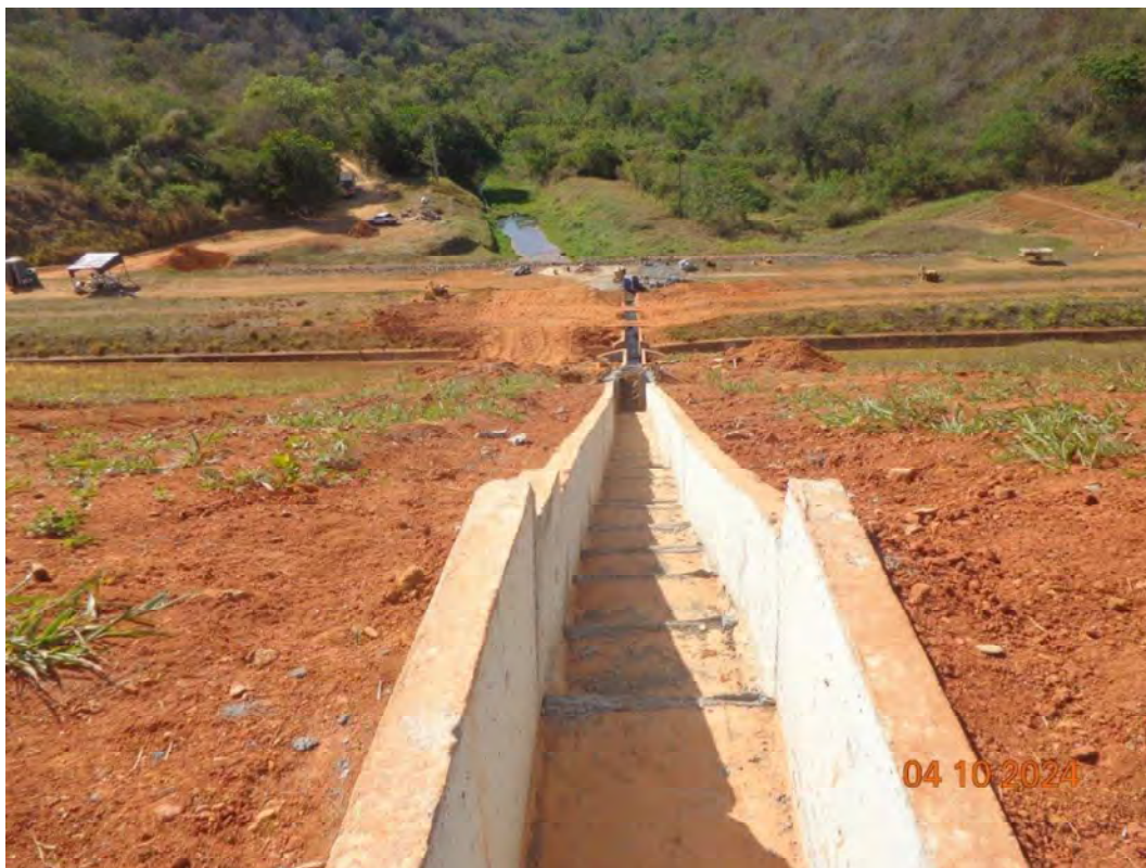
Foto 1 – Descida hidráulica em degraus executada, entre as bermas 510 e 520. Região central. (fonte: inspeção de campo realizado pela equipe da unidade em 04/10/24).
