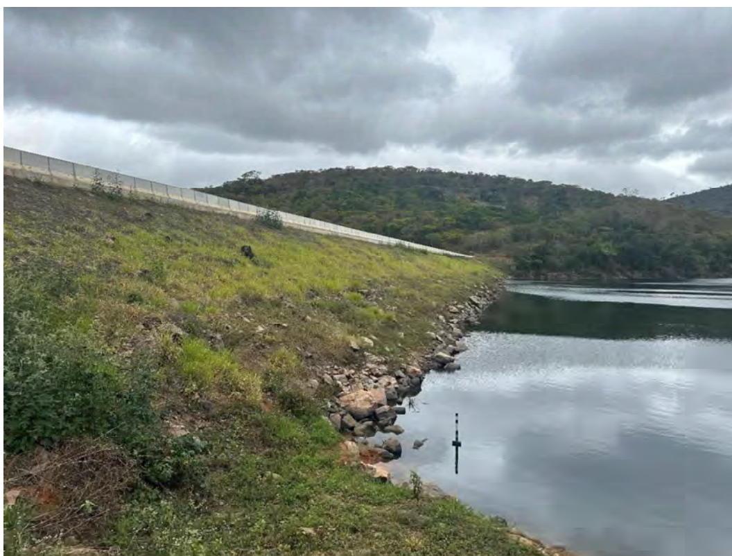
Foto 9 – Talude de montante – Vista para a ombreira direita.
