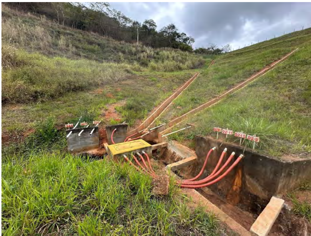
Foto 18 – Drenos horizontais profundos – Berma 500 – Contato com a ombreira esquerda.
