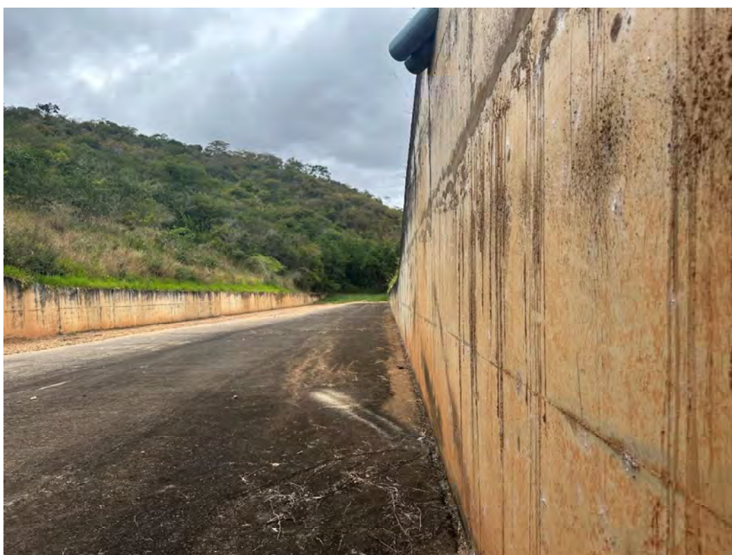
Foto 33 – Estrutura do canal extravasor sem avarias ou sinais de instabilidade.
