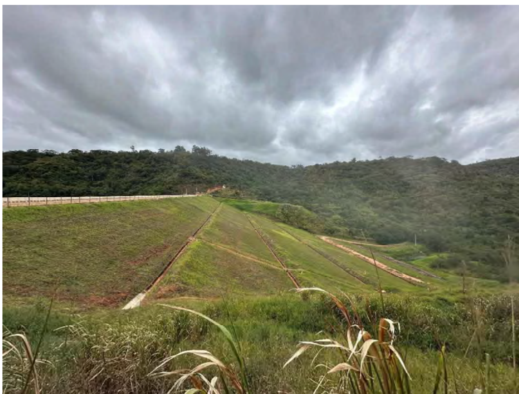
Foto 11 – Talude de jusante – Vista para a ombreira esquerda.
