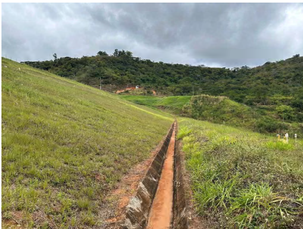
Foto 15 – Talude de jusante – Berma 500 – Vista para a ombreira esquerda.
