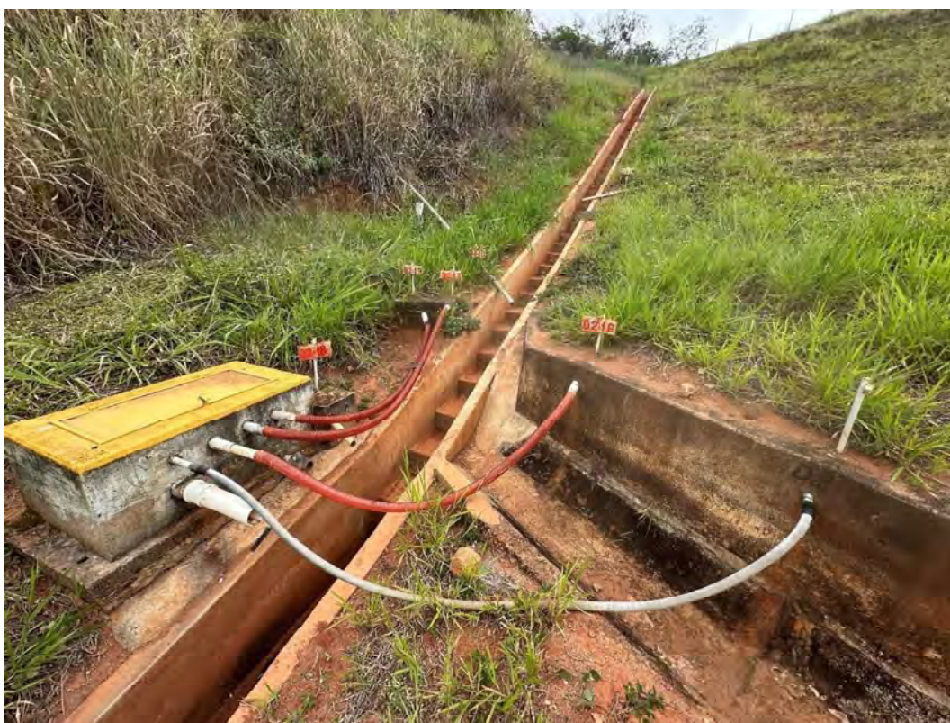
Foto 17 – Drenos horizontais profundos – Berma 510 – Contato com a ombreira esquerda.
