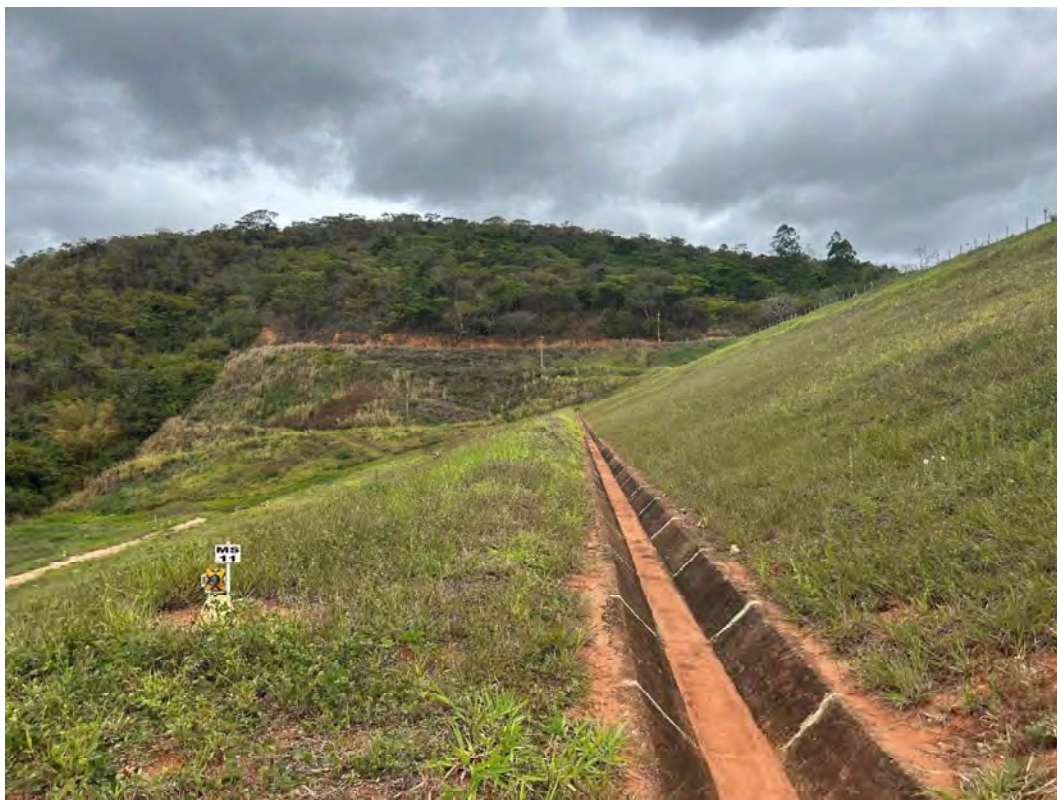
Foto 14 – Talude de jusante – Berma 510 – Vista para a ombreira direita.
