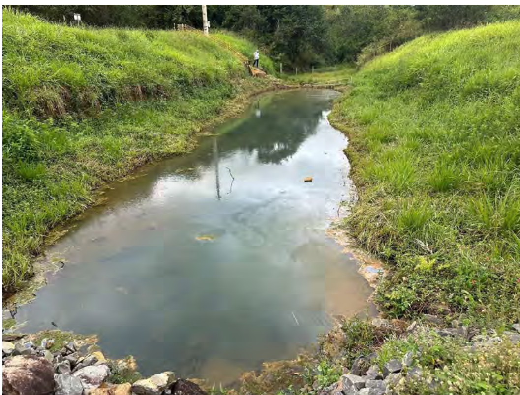
Foto 27 – Medidor de vazão.
