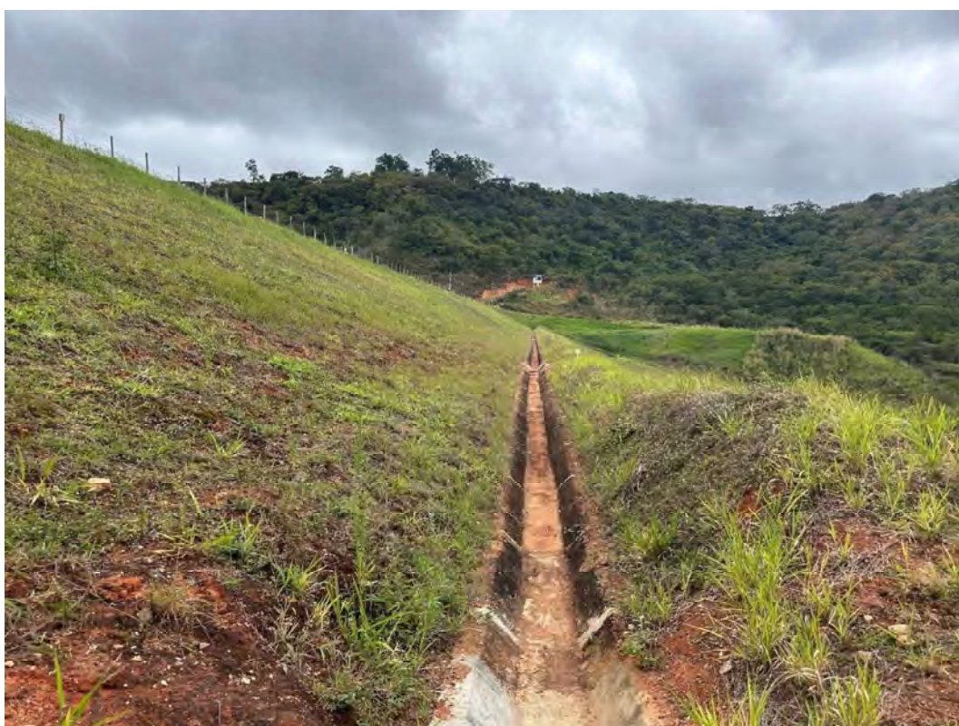
Foto 13 – Talude de jusante - Berma 520 – Vista para a ombreira esquerda.
