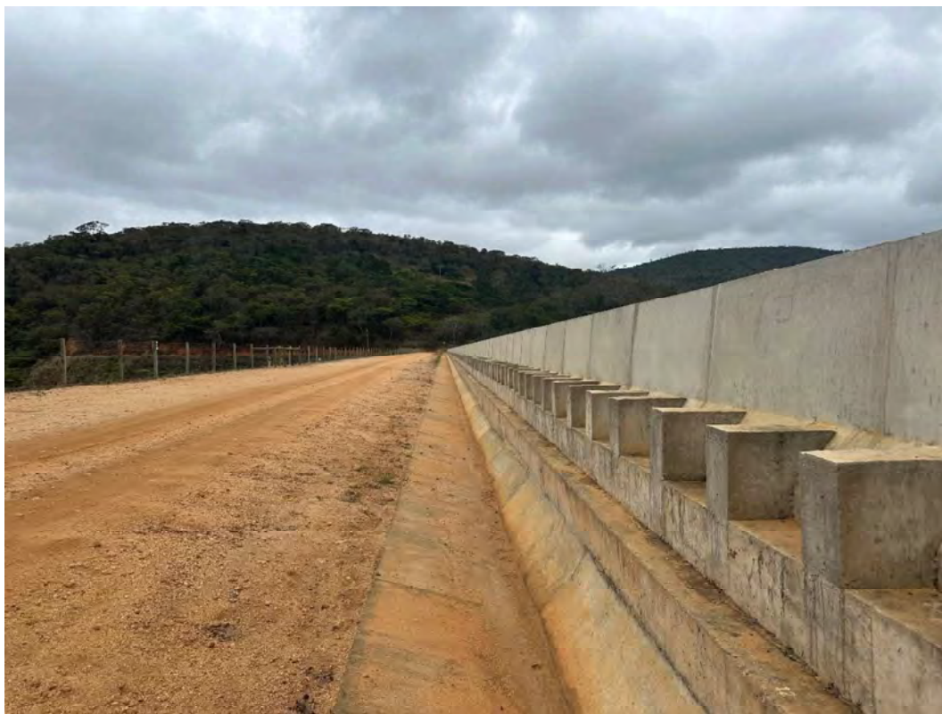
Foto 8 – Muro de regularização da crista, com a canaleta de drenagem – Vista para a ombreira direita.
