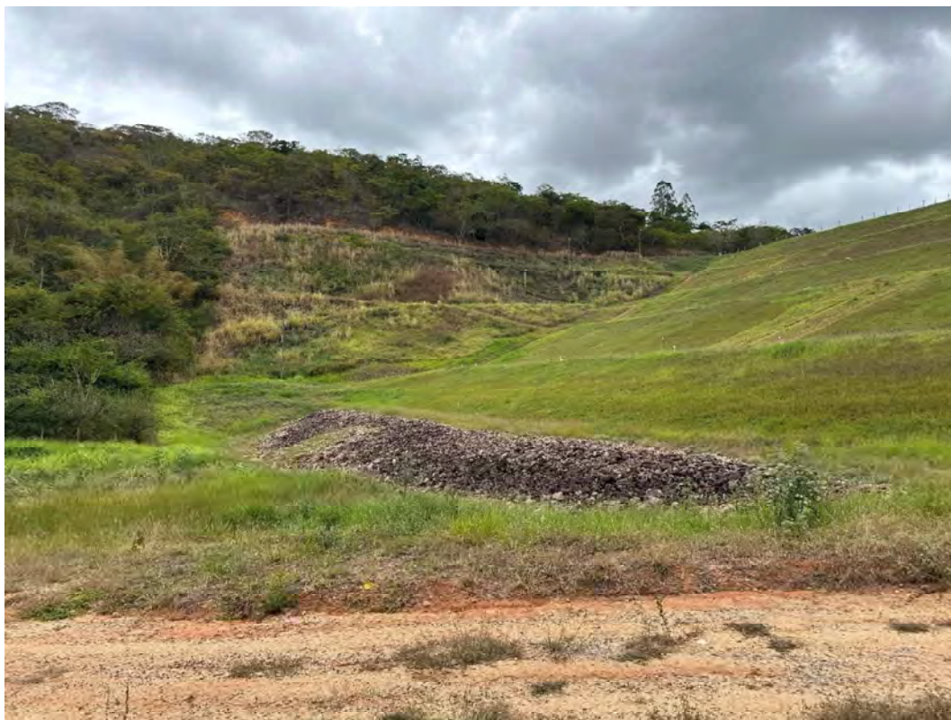
Foto 22 – Talude de jusante – Enrocamento de “pé”. – Vista para a ombreira esquerda.
