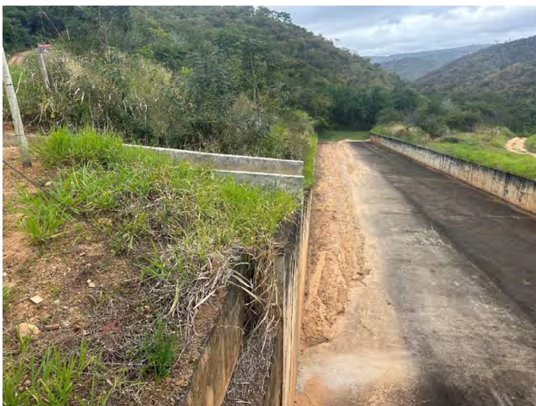
Foto 35 – Drenagem da canaleta da crista descarregando do extravasor.
