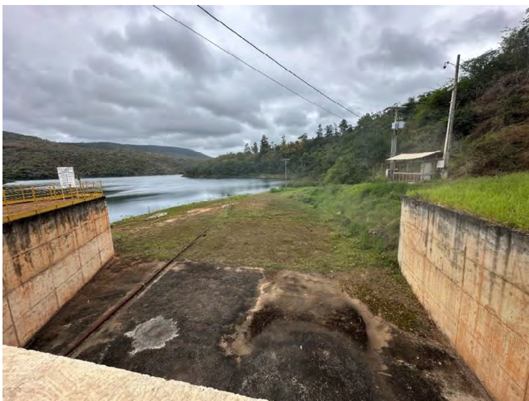
Foto 29 – Canal aproximação do extravasor – ombreira esquerda.
