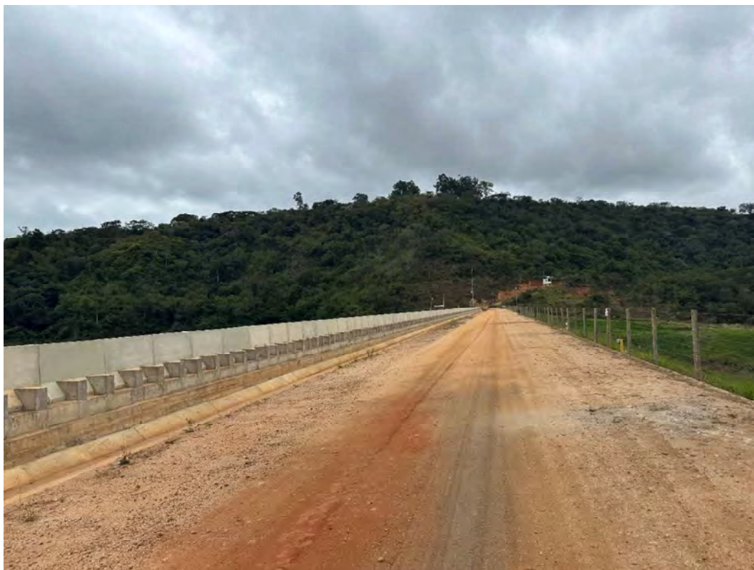
Foto 6 – Crista da barragem - Vista para a ombreira esquerda.
