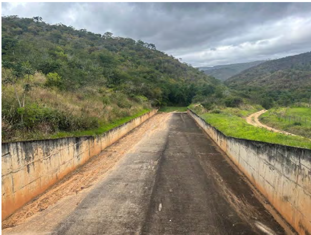
Foto 30 – Canal extravasor – vista para jusante – ombreira esquerda.
