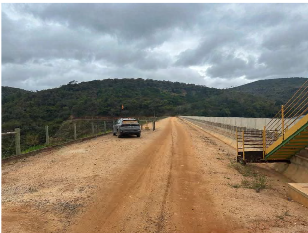
Foto 5 – Crista da barragem - Vista para a ombreira direita.
