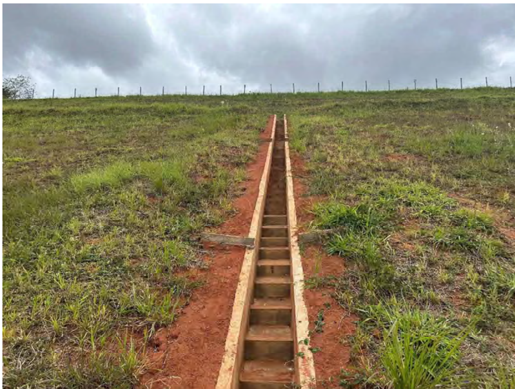
Foto 20 – Descida hidráulica em degraus, na ombreira esquerda, entre as bermas 510 e 520.
