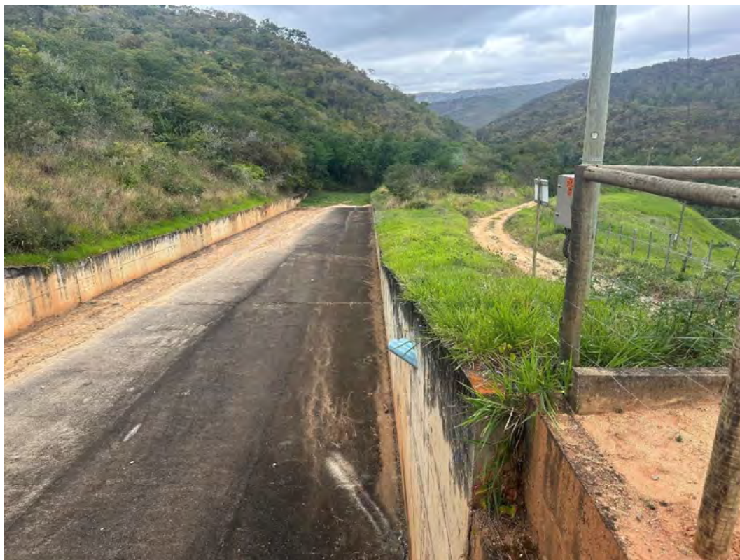
Foto 34 – Drenagem do acesso descarregando do extravasor.
