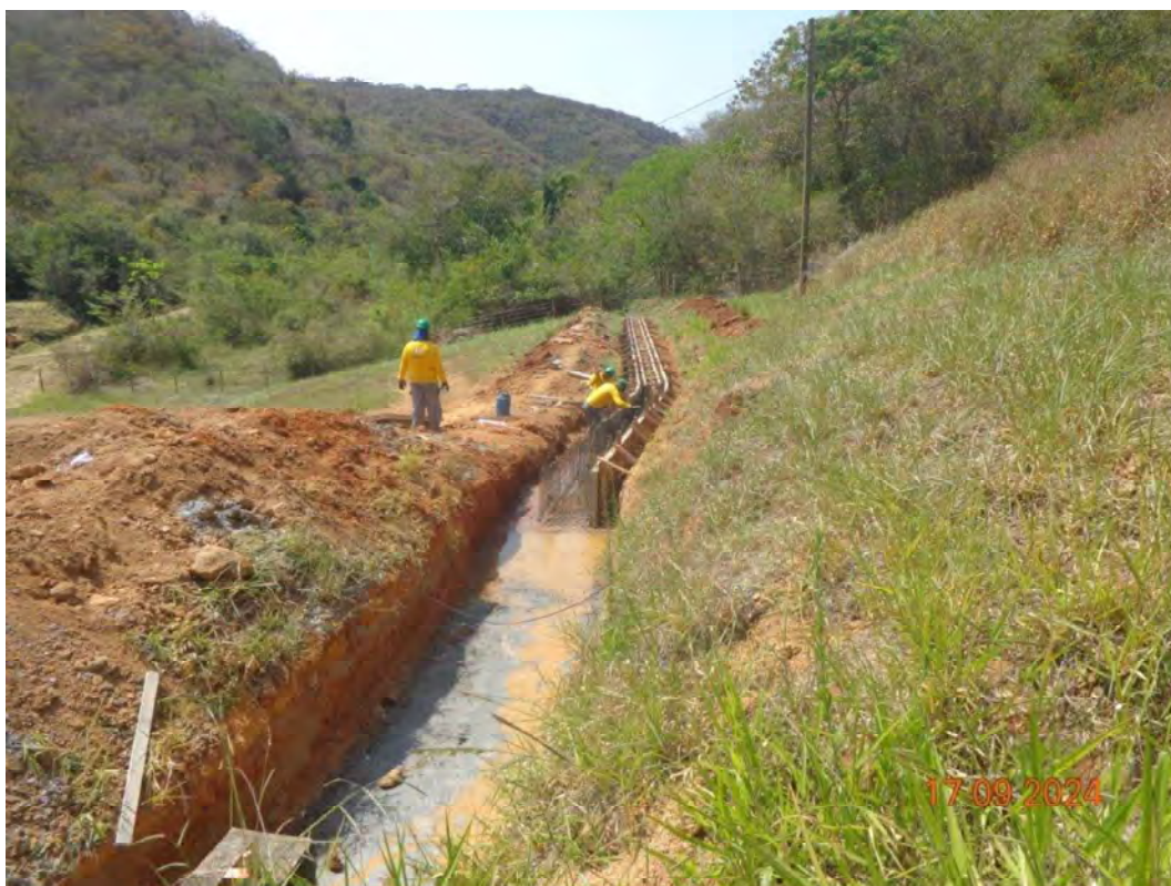
Foto 2 – Reconformação da descida hidráulica no contato com a ombreira direita. (fonte: inspeção de campo realizado pela equipe da unidade em 17/09/24).
