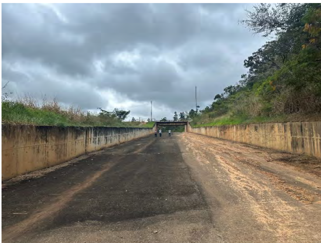
Foto 31 – Canal extravasor – vista para montante – ombreira esquerda.
