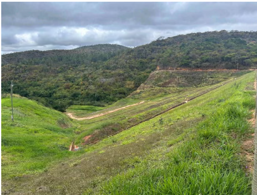
Foto 12 – Talude de jusante – Vista para a ombreira direita.
