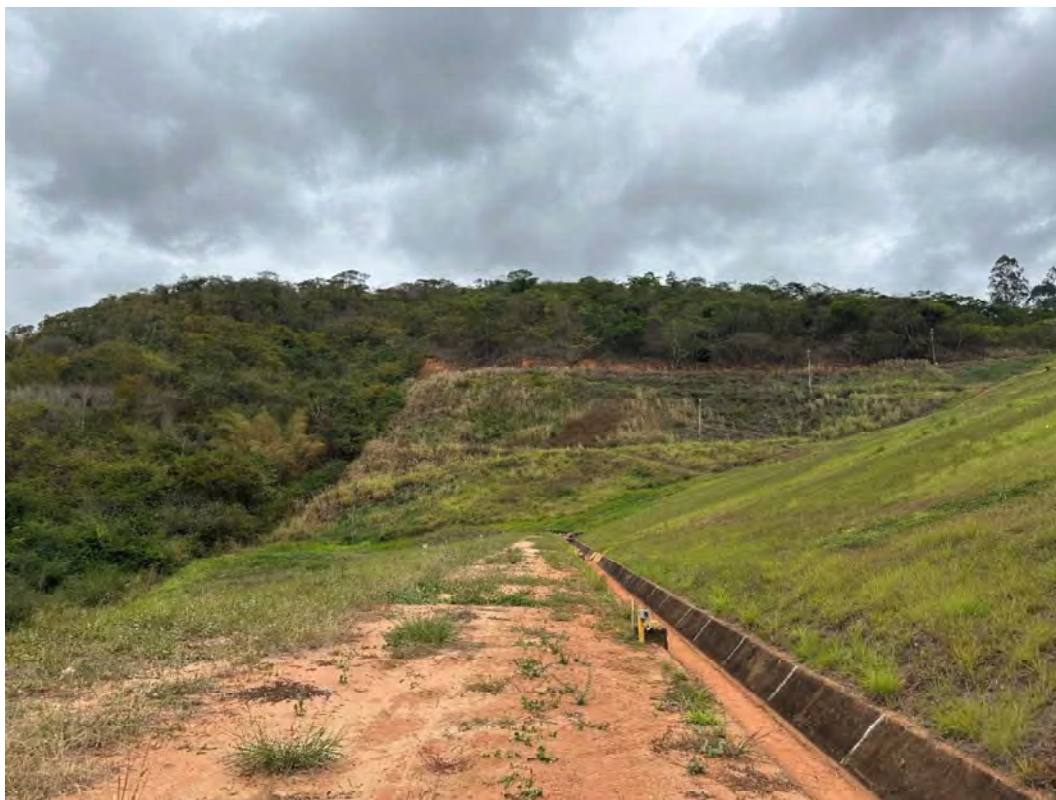
Foto 16 – Talude de jusante – Berma 490 – Vista para a ombreira direita.
