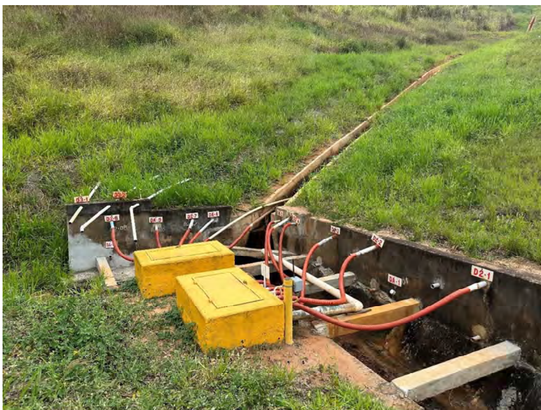
Foto 19 – Drenos horizontais profundos – Berma 490 – Contato com a ombreira esquerda.
