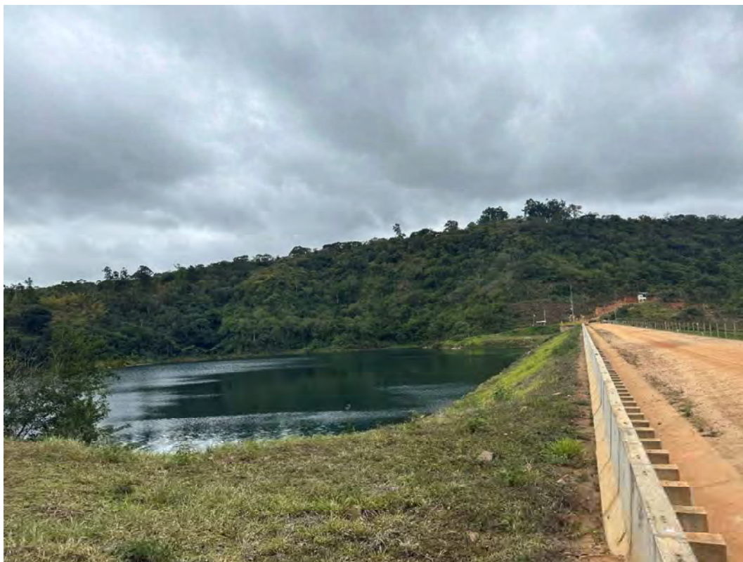
Foto 10 – Talude de montante – Vista para a ombreira esquerda.
