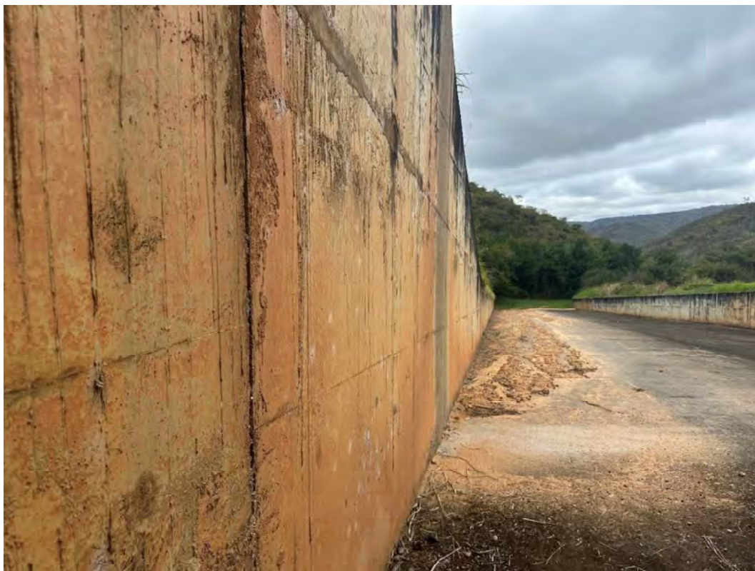
Foto 32 – Estrutura do canal extravasor sem avarias ou sinais de instabilidade.
