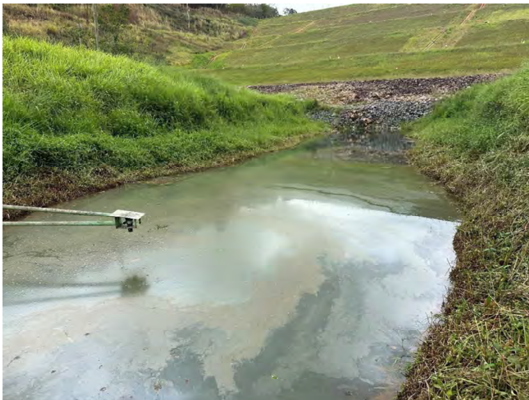
Foto 26 – Saída do dreno de fundo.
