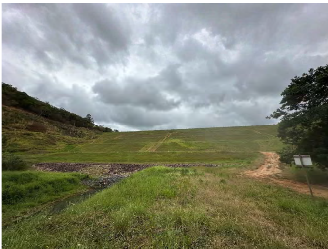
Foto 23 – Talude de jusante – Vista frontal.
