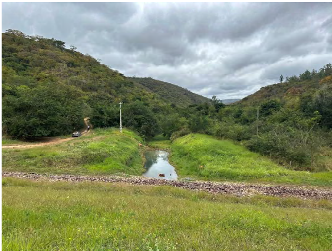
Foto 24 – Área de jusante – Detalhe para a bacia de acumulação do dreno de fundo.
