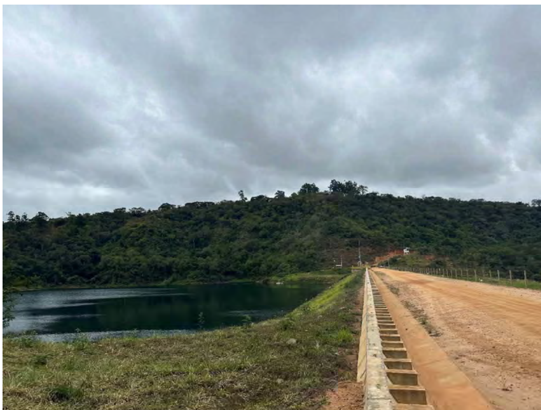
Foto 7 – Muro de regularização da crista, com a canaleta de drenagem – Vista para a ombreira esquerda.
