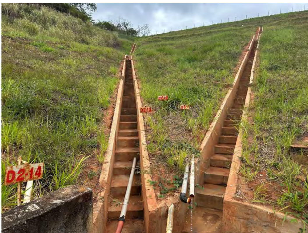
Foto 21 – Descida hidráulica em degraus, na ombreira direita, entre as bermas 510 e 520.
